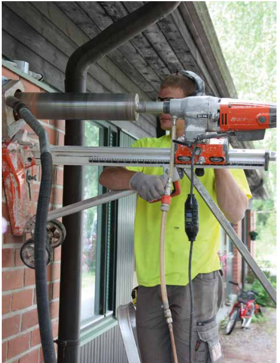
Korvausilmaventtiileille tehtiin uudet reiät tiiliseiniin. Timanttiporaus sujui vaivatta ja nopeasti.
