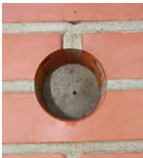
Korvausilmaventtiileille tehtiin uudet reiät tiiliseiniin. Timanttiporaus sujui vaivatta ja nopeasti.
