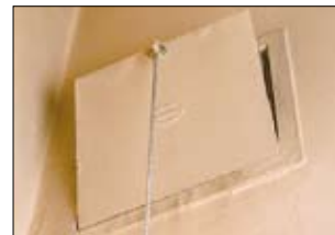
Vanha venttiili poistetaan, rautaventtiilistä pelkkä luuku (mallista riippuen)
