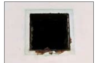
Vanhan venttiilin aukko peitetään uudella asennuslevyllä
